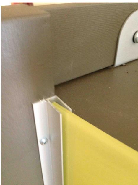
Selon le cas, mettre en place les moniteurs avant de poser les panneaux d'acrylique en vissant les supports sur les cadres verticaux. Ne pas trop serrer les vis du support.
