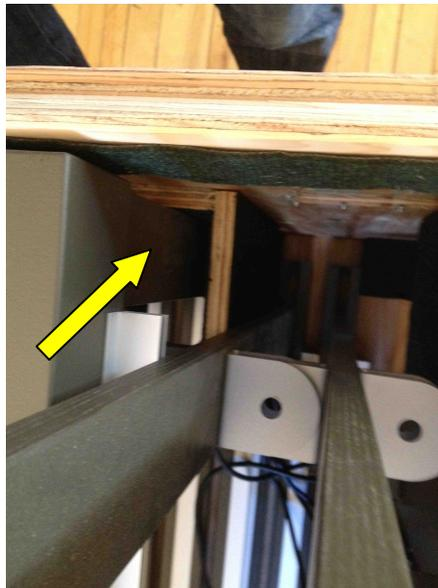
Les panneaux d'acrylique sont ensuite insérés entre les derniers cadres rangés et les supports de moniteurs. Insérer les bandes de carton entre les cadres et le premier panneau pour le protéger. Insérer ensuite les caissette de styromousse contenant les lampes entre les supports des appareils audio-visuels.
